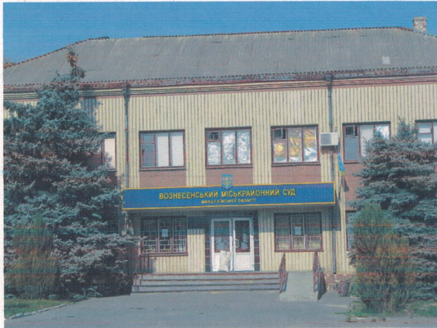
Рис. 3.1. Будівля Вознесенського міськрайонного суду Миколаївської області
